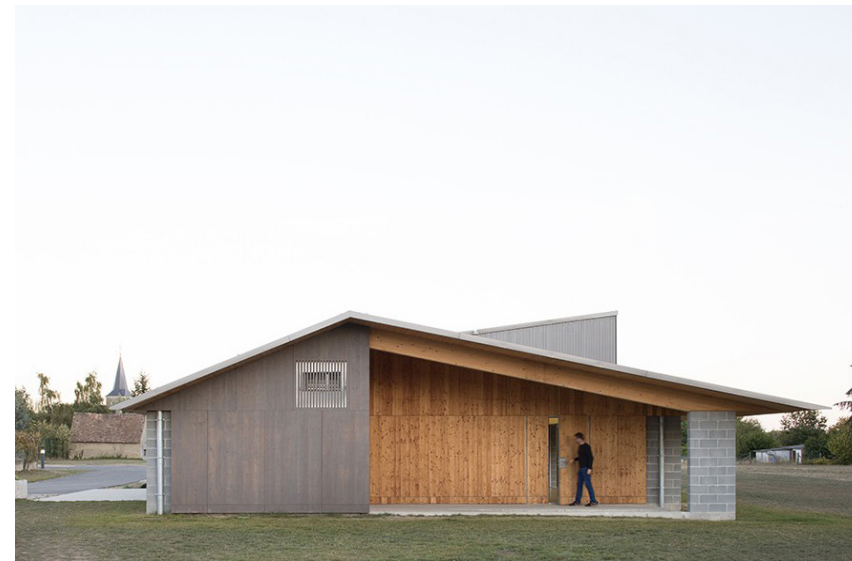
Salle des polyvalente Saint-Jean-du-Bois, France -Structure bois lamellé-collé, bloque béton -Bardage façade bois -Menuiserie aluminium laquée. -Sol carrelé -Couverture tole extrudée type tôle ondulé
