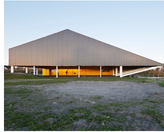
Bardage façade tôle extrudée type tôle ondulé
