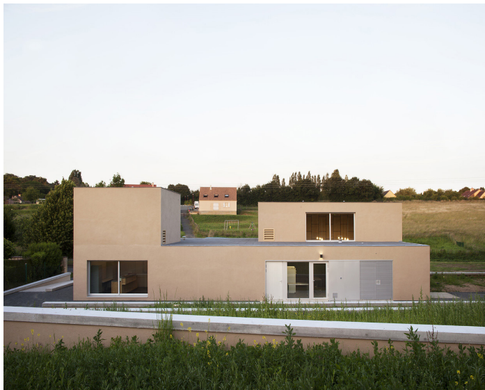
Façade maçonnée enduite
